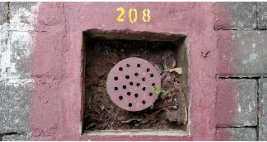
Model Biopori di Area Paving, Universitas Diponegoro
